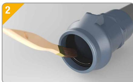
**2. Lubricar la junta:** conseguiremos un montaje más sencillo y evitaremos dañar la junta.
